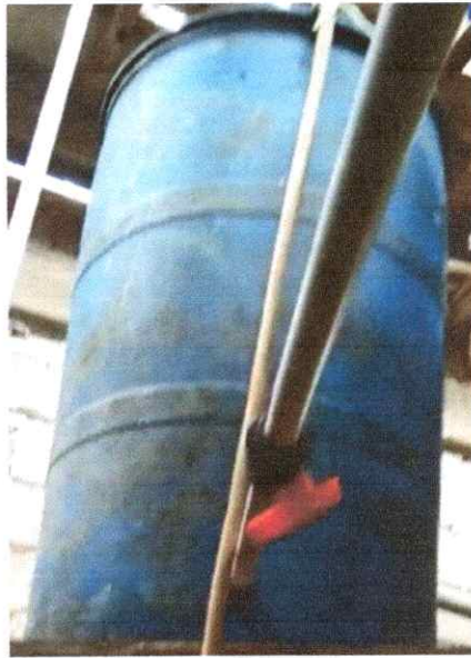
Gambar 3. Tabung Reservoir Tipe Tandon Ukuran 200lt
