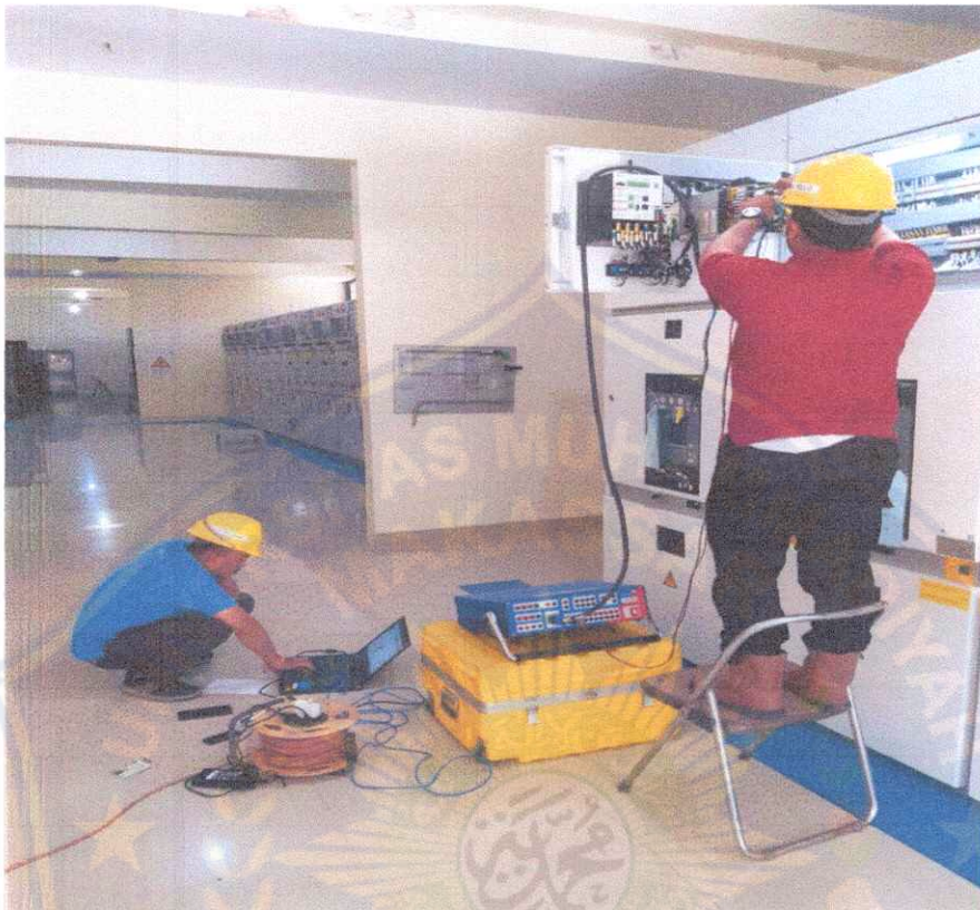
Gambar 5.8 : Pengujian Relay OCR
