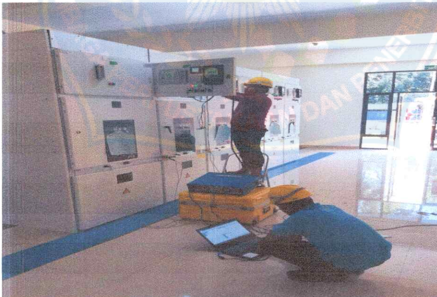
Gambar 5.9 : Pengujian Relay GFR
