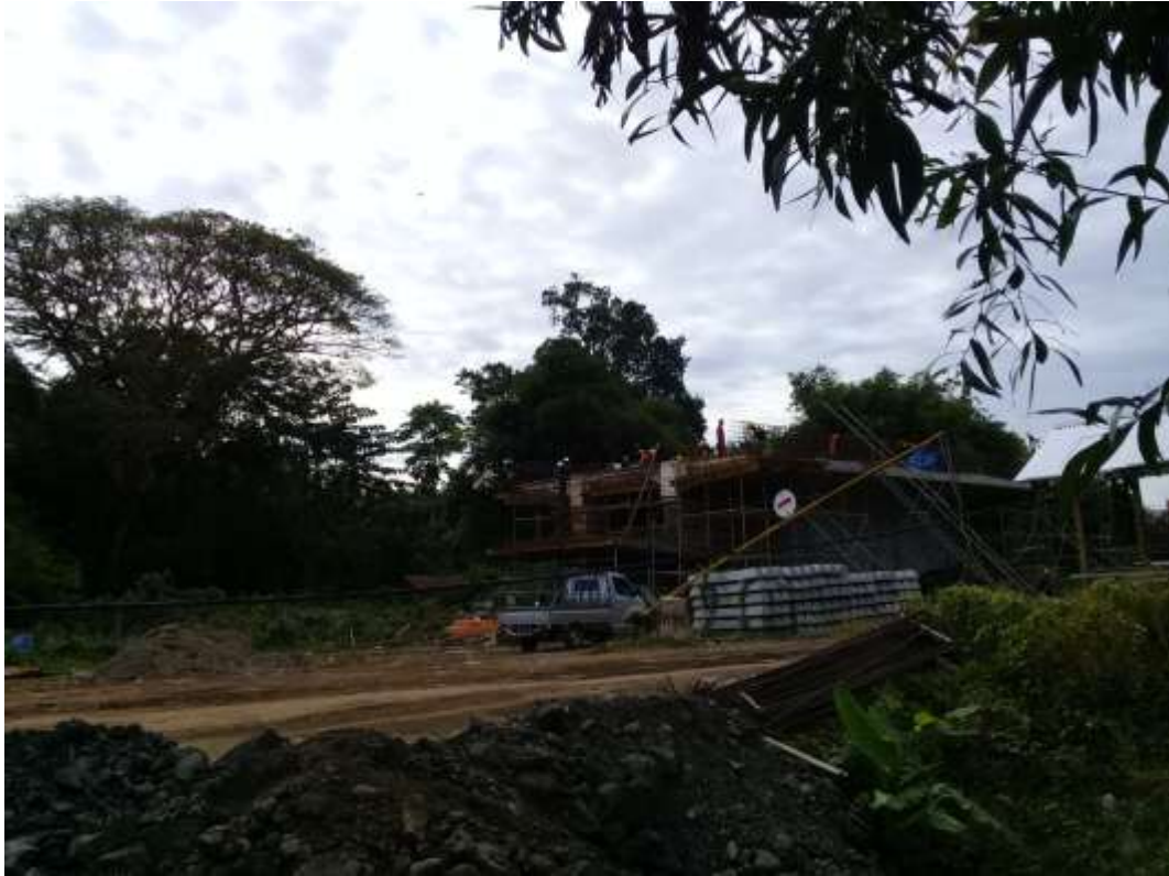
Lokasi Pembangunan Rel Kereta Api
