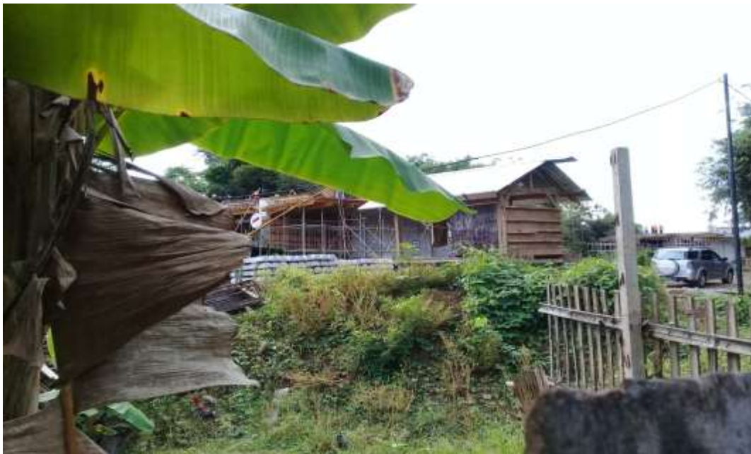
Lokasi Pembangunan Rel Kereta Api
