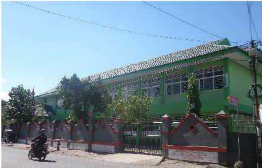
Pagar Sekolah Sebelum Pengecatan
