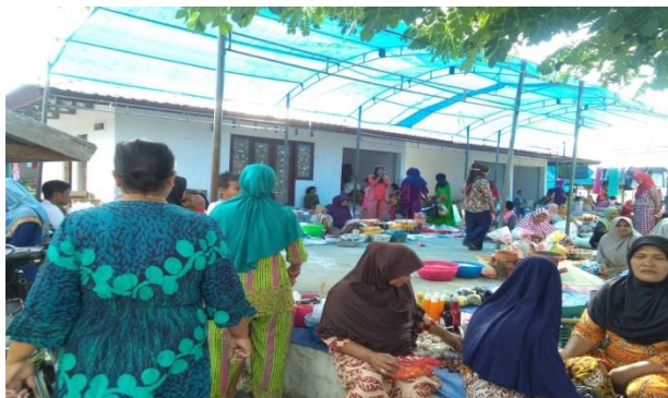
Gambar 4.14 Kondisi Bangunan di Pasar Baru Kecamatan Pasimarannu
