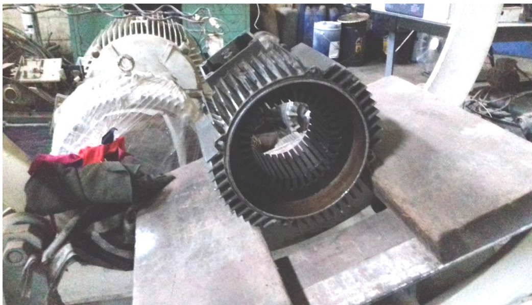
Kondisi Motor Sebelum Digulung Ulang
