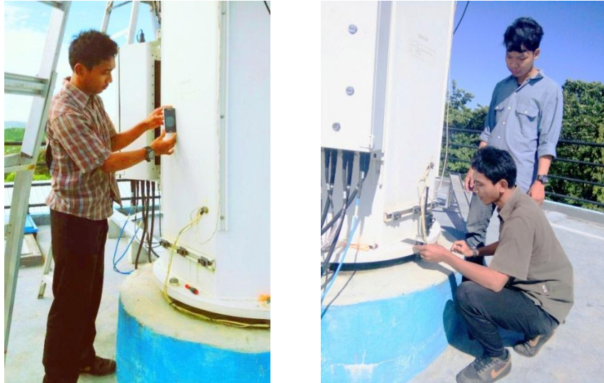
Gambar 4.25 Pengukuran sudut kelurusan antenna menggunakan Inclinor
