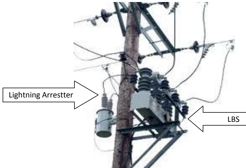
Gambar 2.5 Penggunaan lightning arrestter dan LBS remote
