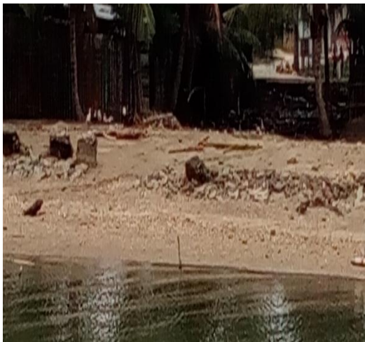
Hasil Kerusakan Daerah Pesisir Pantai akibat abrasi
