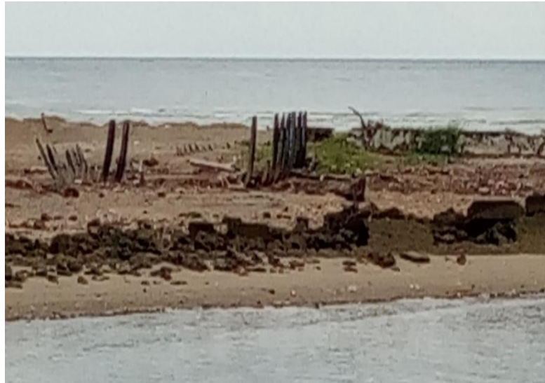
Bekas Kerusakan yang Disebabkan Oleh Abrasi yang Terjadi
