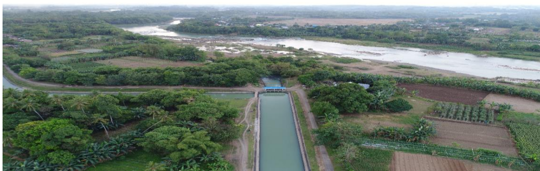
Gambar 8. Pintu Pembuang, Penguras Lumpur dan Pintu Saluran Induk (Primer) Daerah Irigasi Kampili
