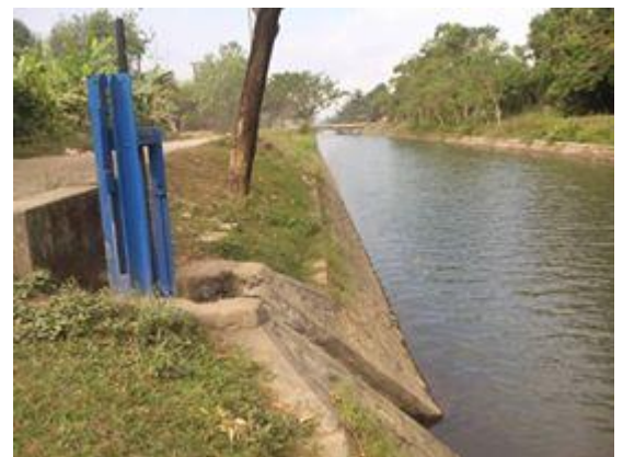
Gambar 7. Saluran Tersier (Bangunan Sadap) Daerah Irigasi Bendung Kampili
