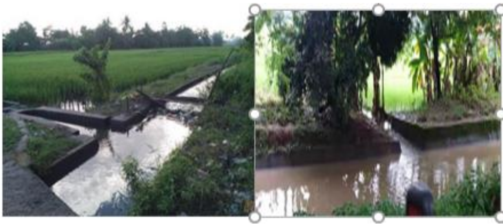
Gambar 13. Saluran tersier tanpa pintu
