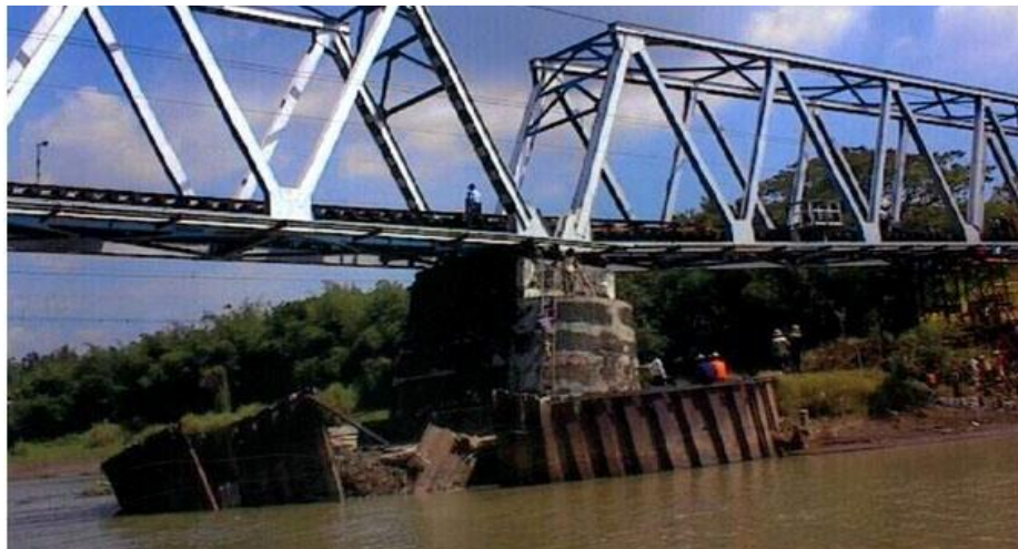
Gambar 5. Jembatan kereta api di Comal, Jawa Tengah, 2001 (Istiarto, 2011)
