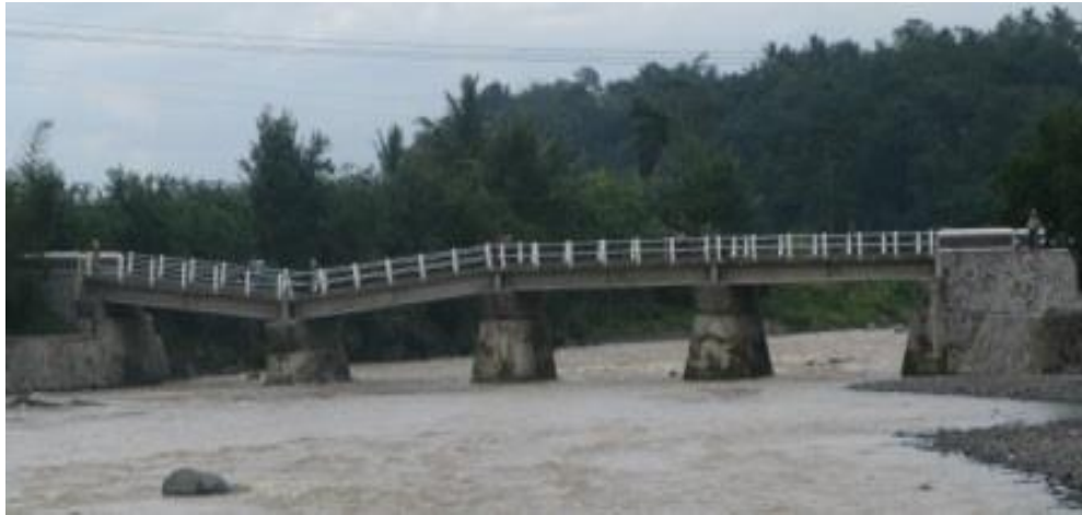
Gambar 3. Jembatan Trinil, Magelang, 2009 (Istiarto, 2011)
