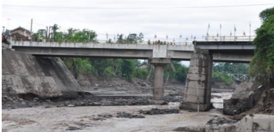
Gambar 4. Jembatan Pabelan di jalan raya Yogyakarta - Magelang pada Maret 2011(Istiarto, 2011)
