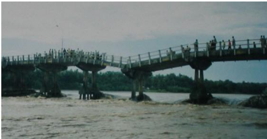
Gambar 1. Jembatan Srandakan, Kulon Progo, Yogyakarta (Istiarto, 2011)
