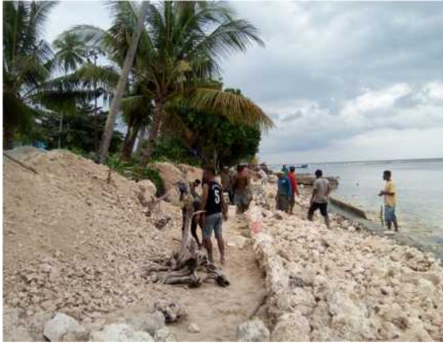
Gambar : masyarakat memperbaiki bagian pantai yang terkena dampak reklamasi
