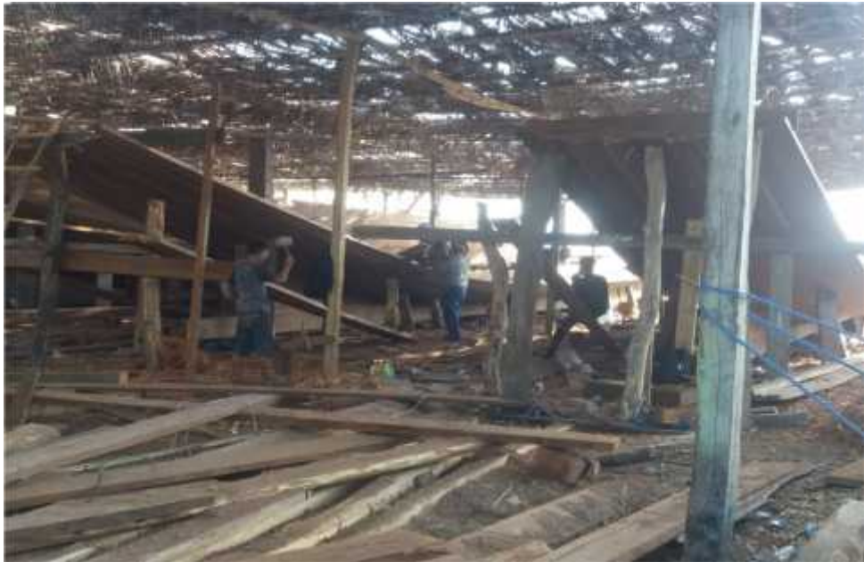
Gambar 8. Proses Pembuatan Perahu Pinisi Secara Tradisional Oleh Masyarakat Pekerja Perahu Pinisi di Kelurahan Tanah Beru
