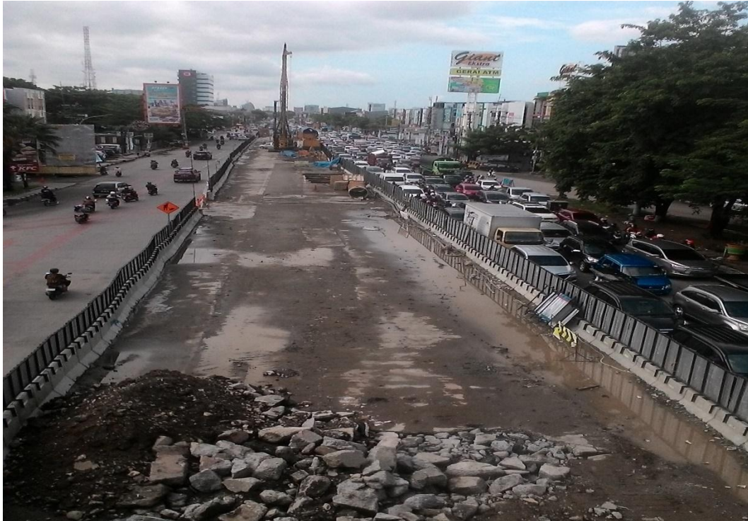
Gambar 5.1. Suasana proses pembangunan jalan tol layang A.P Pettarani.
