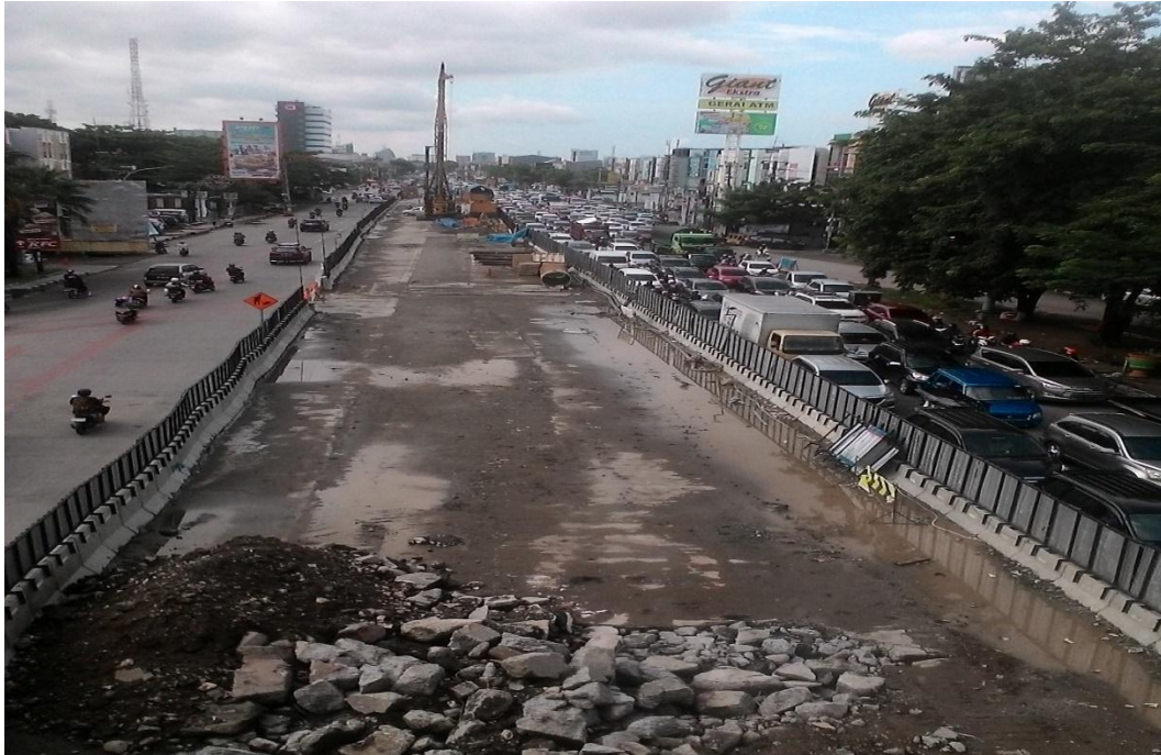
Keterangan Kegiatan 1 : suasana pembangunan jalan tol layang A.P Pettarani
