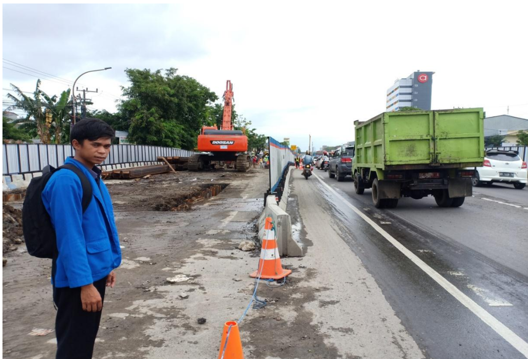
Keterangan kegiatan 6 : kendaraan proyek yang melintasi jalan A.P Pettarani
