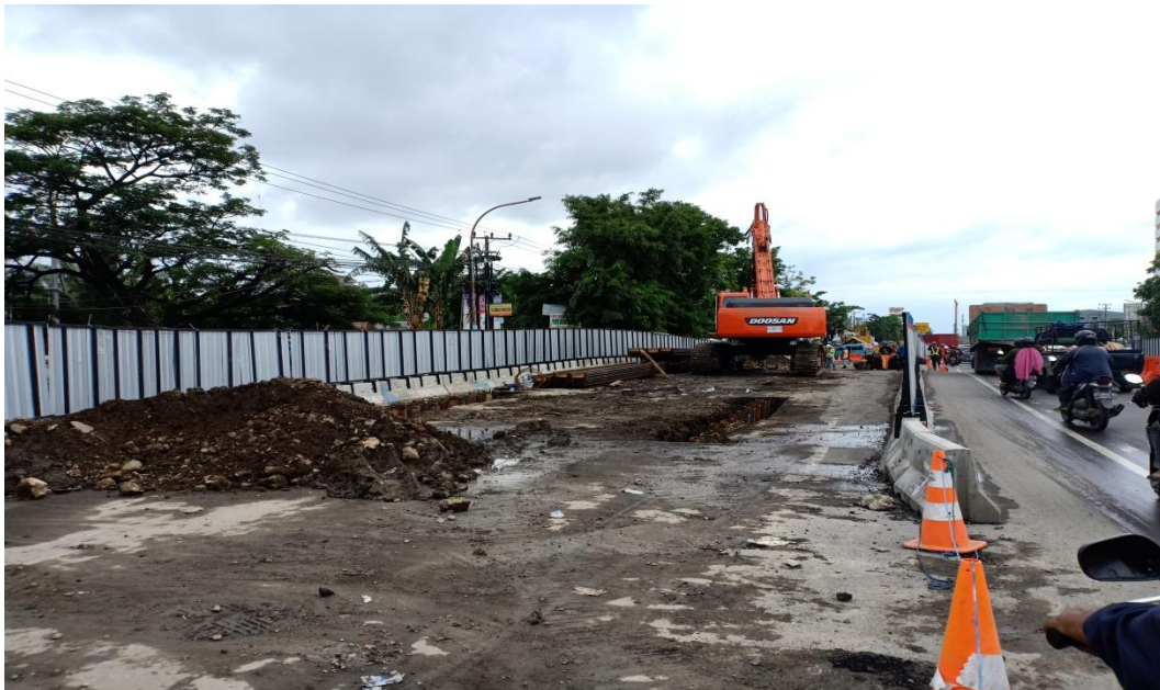
Keterangan Kegiatan 2: proses pembangunan jalan tol layang A.P Pettarani
