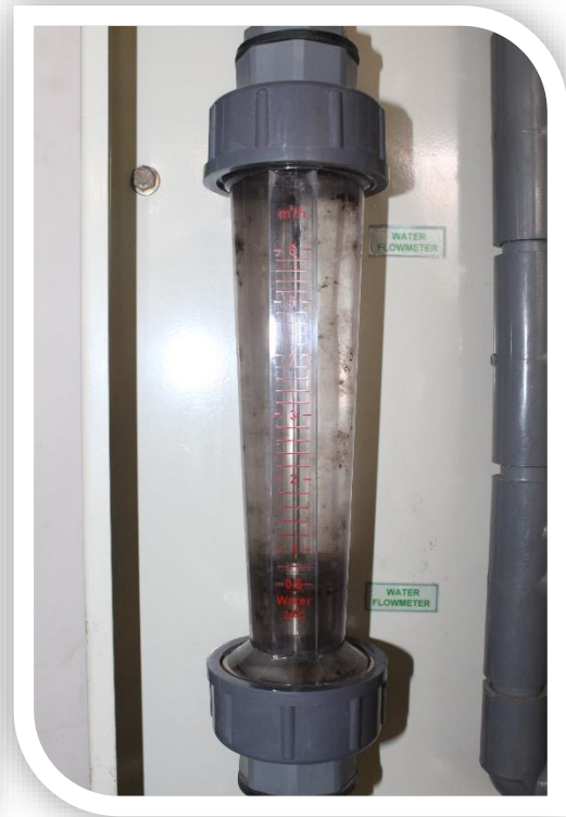
Gambar. 27 Pengaturan Debit Pada Flowmeter
