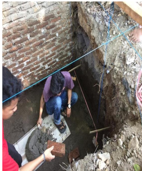
Proses pemasangan bata dan plasteran
