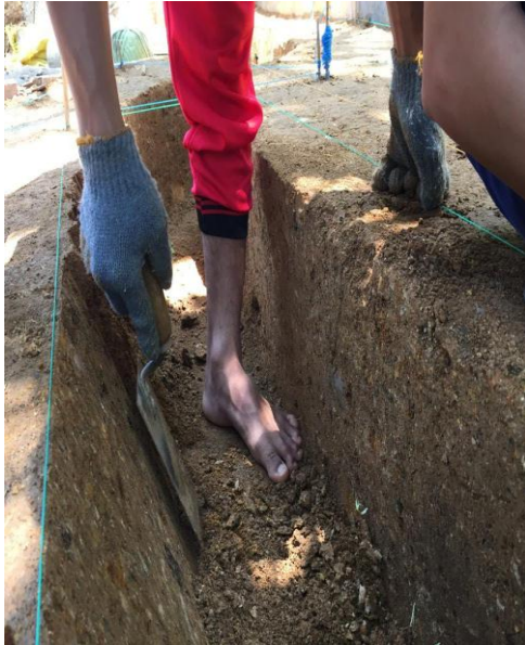
Proses pembuatan lebar bawah saluran dengan lebar 30 cm
