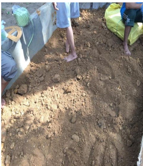
Proses penmbunan tanah
