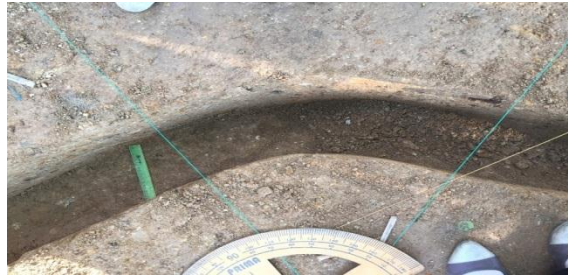
Gambar 22. Pembuatan Tikungan Saluran
