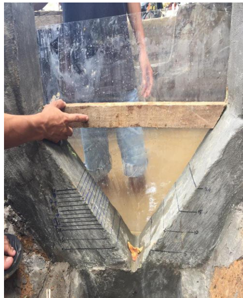
Proses pemasangan pintu thompson
