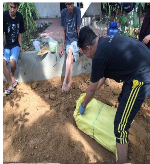
Proses pemadatan tanah menggunakan beton
