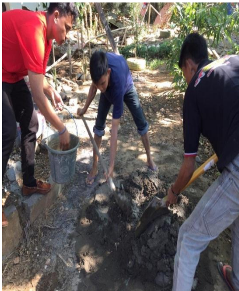
Proses pencampuran untuk pasangan bata
