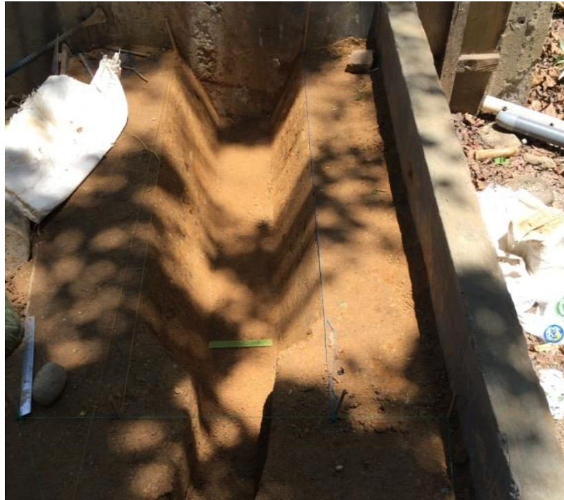
Gambar 20. Dimensi Saluran Trapisium.
