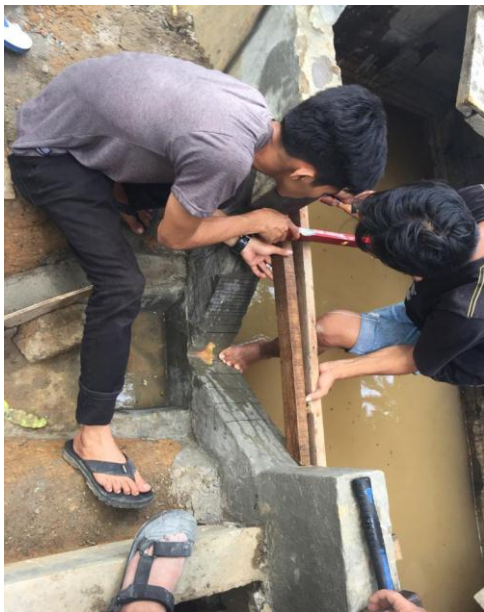
Proses pekerjaan stan pintu thompson
