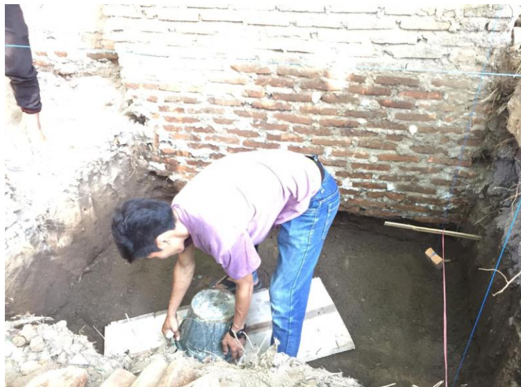
Gambar 19. Pembuatan Bak Penampung Air
