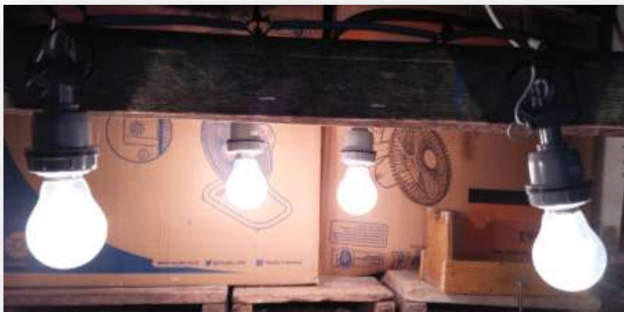
Proses percobaan pada kWh meter
