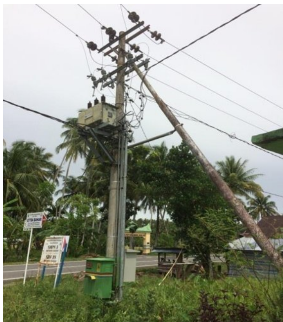
Gambar 2.7 Konstruksi Saluran Udara Tegangan Menengah
