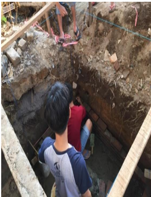
Proses Pembuatan Bak Penampungan
