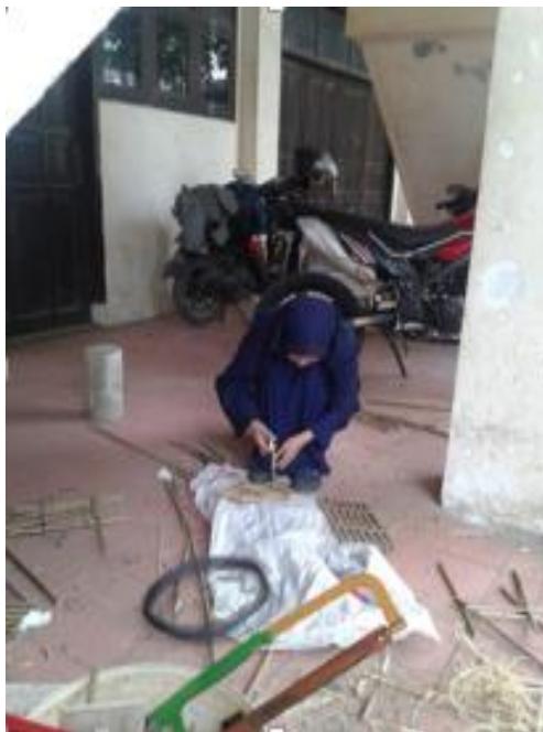
Proses Pembuatan Krib Semi Permeabel
