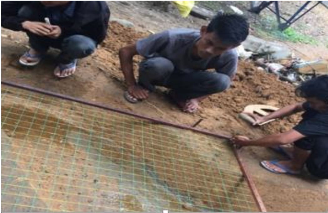
Proses Pemasangan Grid
