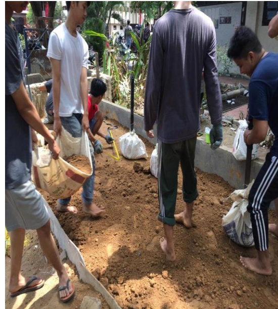
Proses Pematatan Timbunan
