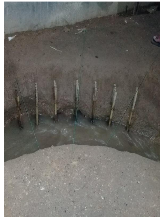
Hasil Gerusan saat pemasangan Krib
