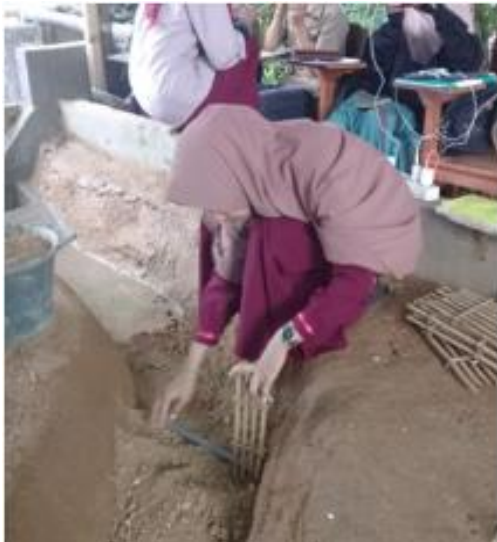
Proses Pemasangan Krib Semi Permeabel
