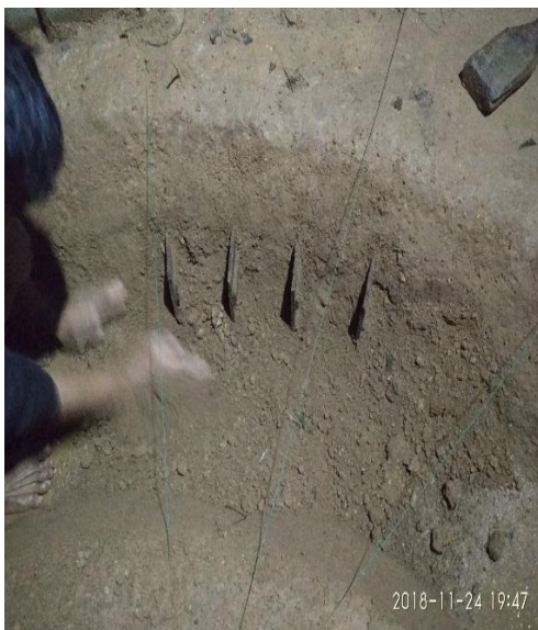
pemasangan krib impermeable
