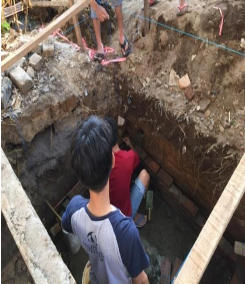
Pembuatan Bak Penampungan
