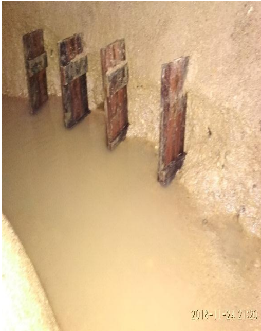
Hasil Gerusan saat pemasangan Krib
