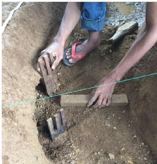
Gambar Lampiran 15. Proses Pemasangan Krib Semi Permeabel
