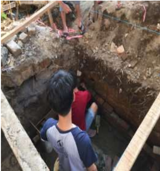
Proses Pembuatan Bak Penampungan
