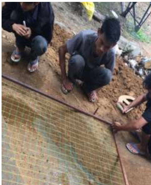
Proses Pemasangan Grid
