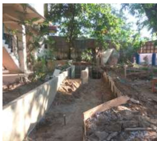
Proses Pemasatan Tanah
