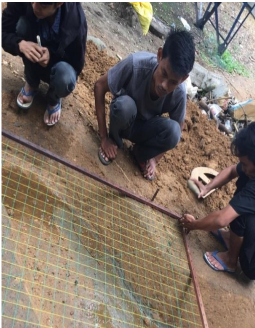
Proses Pemasangan Grid
