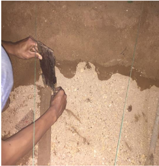
Proses Pemasangan Krib Impermeabel
