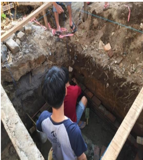
Proses Pembuatan Bak Penampungan
