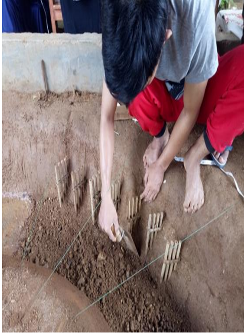
Pemasangan gemburan tanah pada tebing saluran
