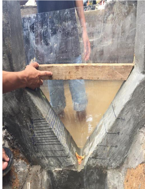
Proses pemasangan pintu thompshon (V-Notch)
