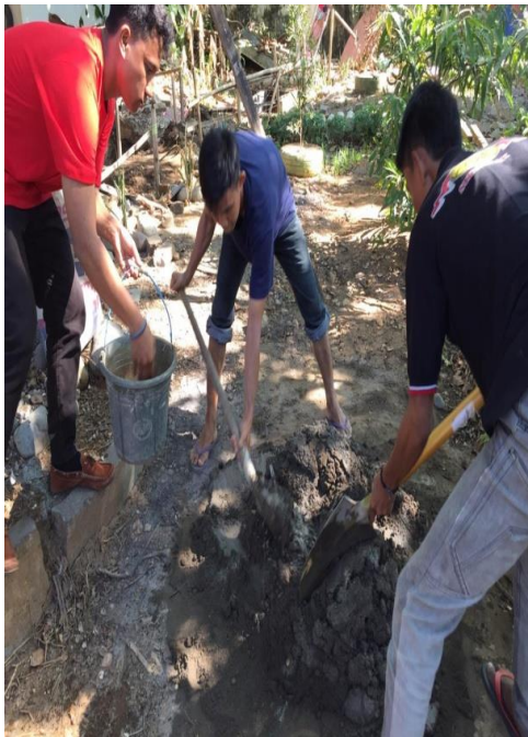
Proses pencampuran semen untuk pelasteran dan susunan bata
