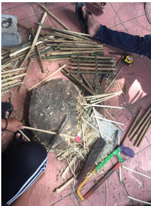
Proses pekerjaan krib permeabel
