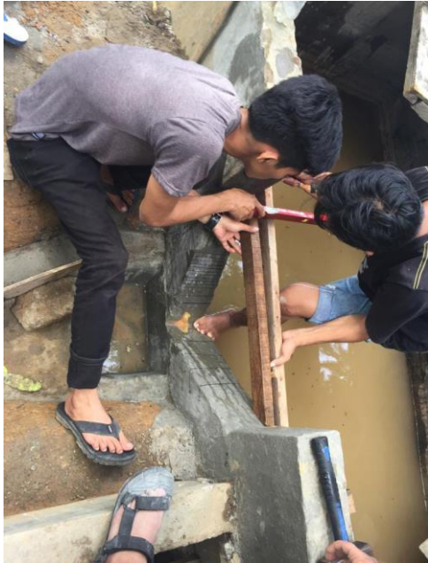
Pekerjaan stan pintu thompshon (V-Notch)
