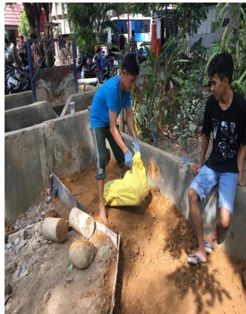
Proses pemasatan tanah menggunakan beton
