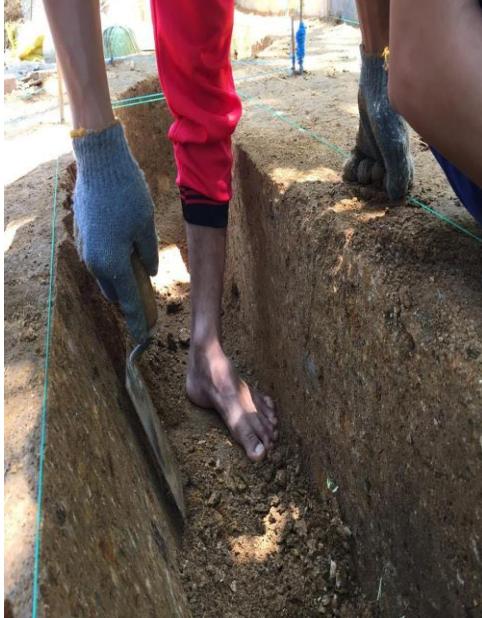
Pembuatan lebar bawah saluran dengan lebar 30 cm
