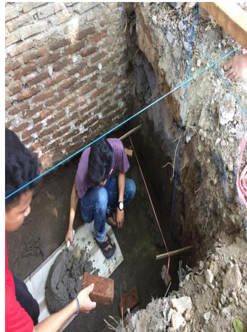
Pekerjaan susunan bata dan pelasteran bak penampungan
