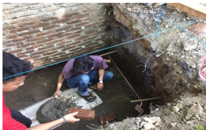
Gambar 17. Pembuatan Bak Penampung Air
