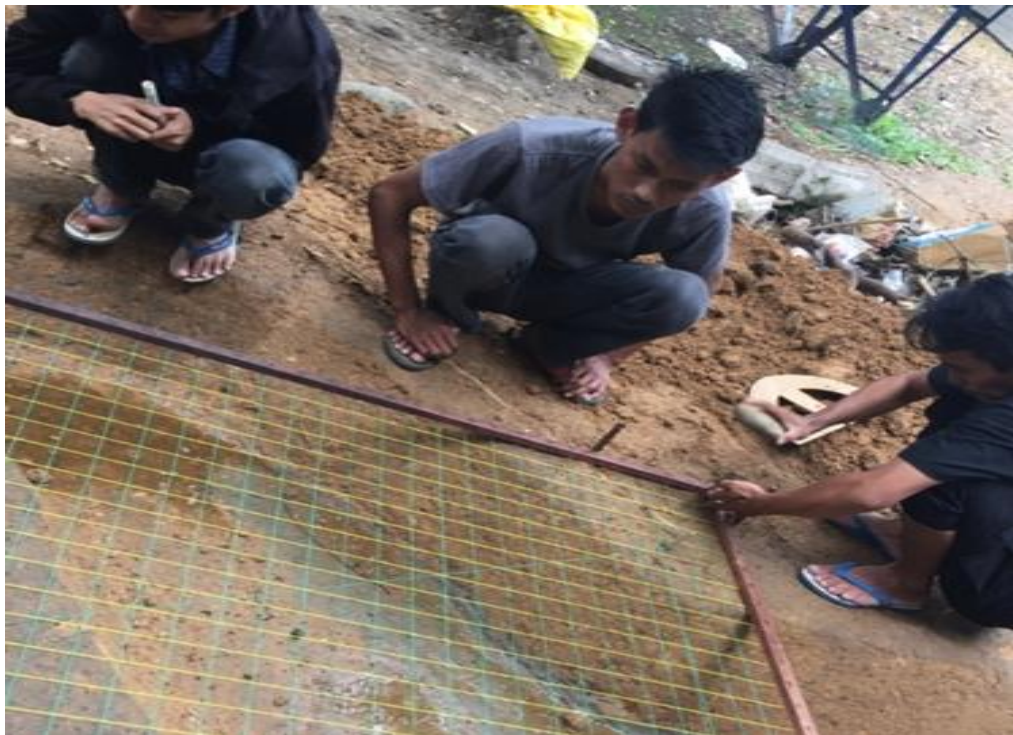
Pengukuran kontur atau topografi saluran menggunakan grid
