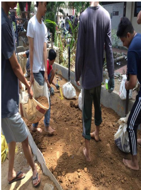
Proses penimbunan tanah saluran sebelum dilakukan pemasatan
