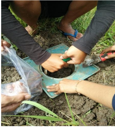
Pengujian Sand Cone Lapangan
