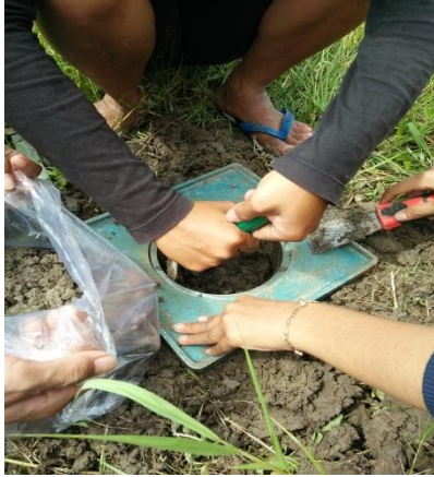
Pengujian Sand Cone Lapangan
