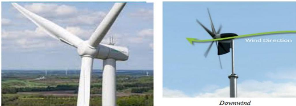
Gambar 2.9 Turbin angin jenis *upwind* dan *downwind*
