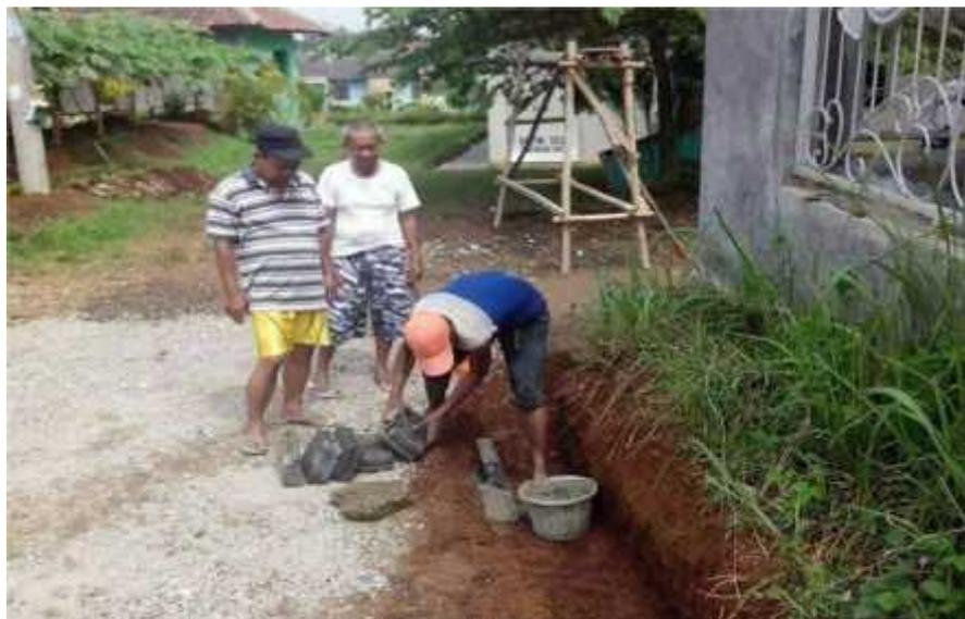
Gambar diatas merupakan kondisi dari pembuatan selokan yang dimana masyarakat sekitar mencoba membuatnya dengan peralatan sederhana tanpa bantuan pemerintah, keadaan seperti ini bukan hanya pada wilayah pedalaman Reo tetapi juga didaerah Kecamatan Reo yang pada dasarnya dipenuhi perumahan.
