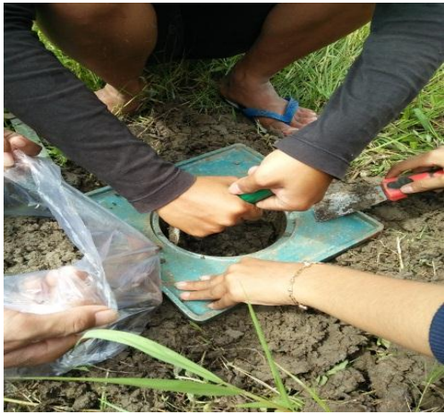
Pengujian Sand Cone Lapangan
