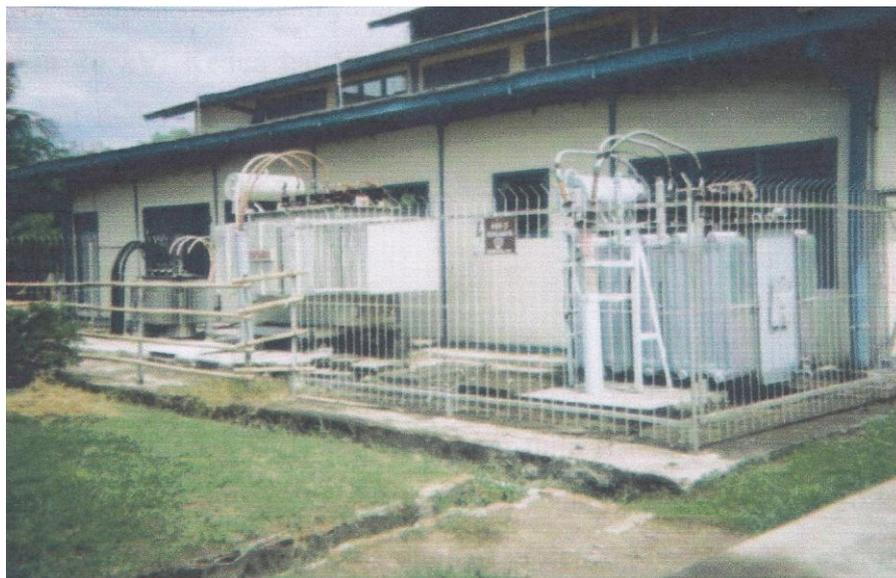
Gambar 3-8. Trafo Step Up 6,3 kV - 20 kV PLTD Sinjai
