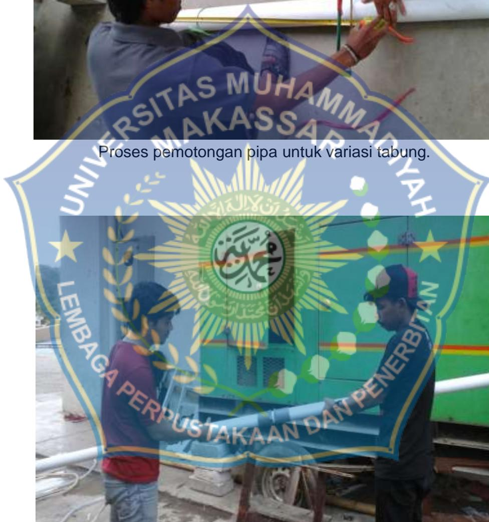
Proses penyambungan pipa untuk variasi panjang pipa
