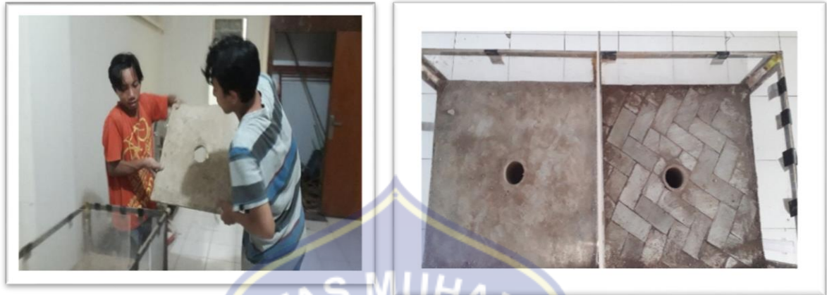
Gambar. 23 Pemasangan Media Tutupan
