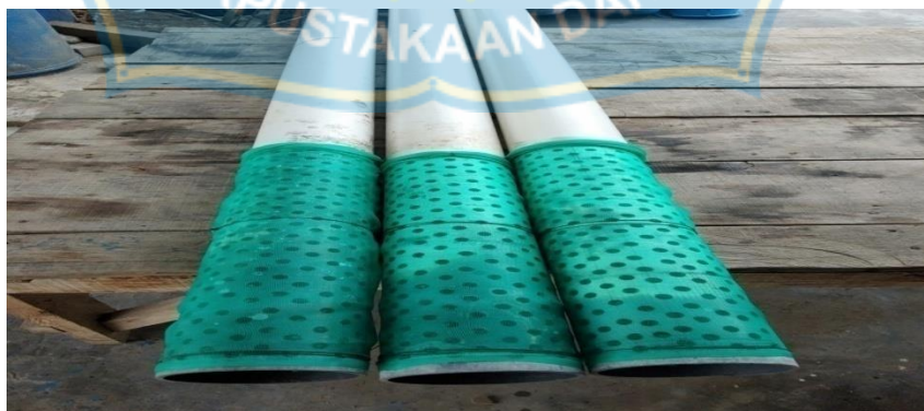
(Pipa sentral drain yang sudah di pasangi saringan)
