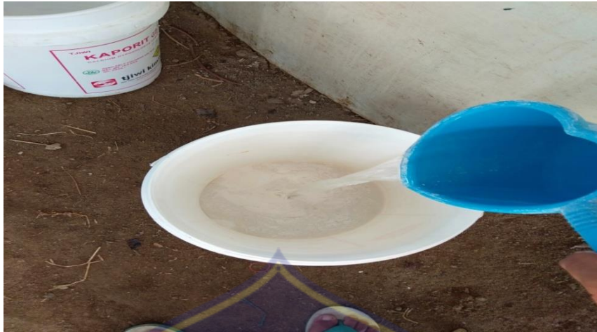
(Pencampuran kaporite dengan air di bak)
