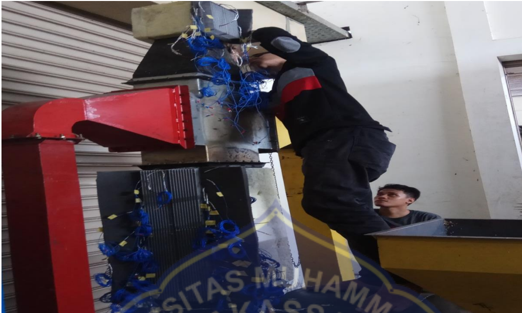
GAMBAR 9. PEMASANGAN DUDUKAN TEG PADA CEROBONG ATAS
