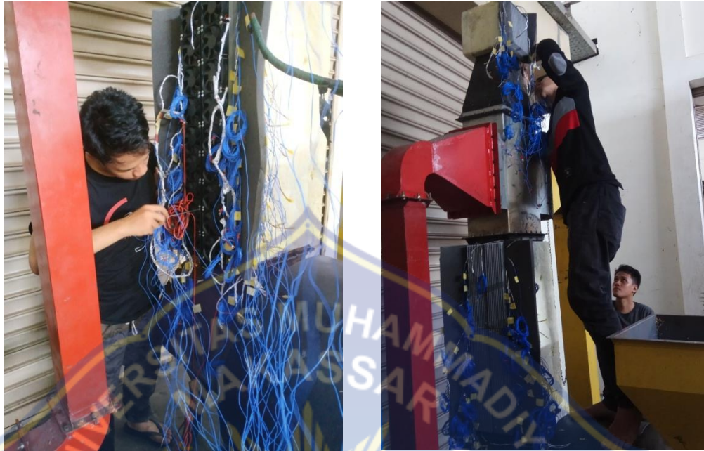
Gambar 3.14 Dudukan TEG pada cerobong atas dan bawah insinerator
