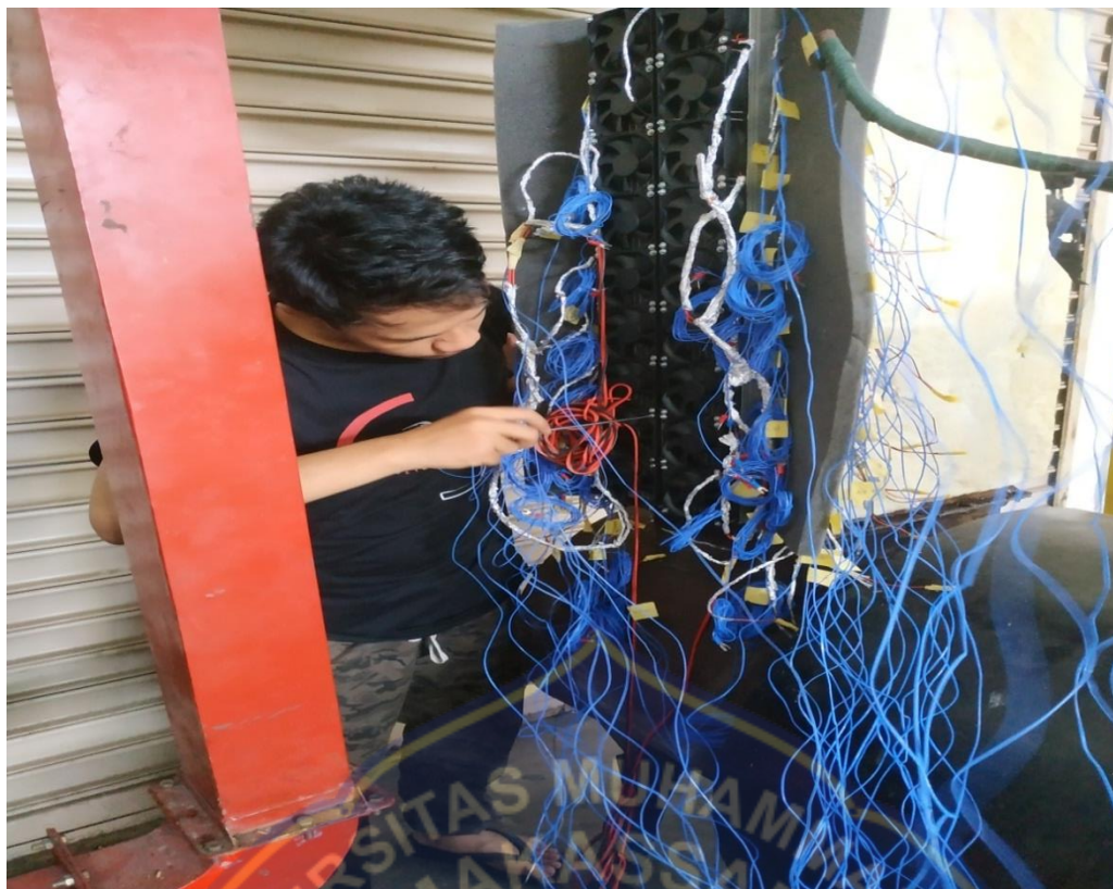
GAMBAR 11. PROSES PENGECEKAN KABEL
