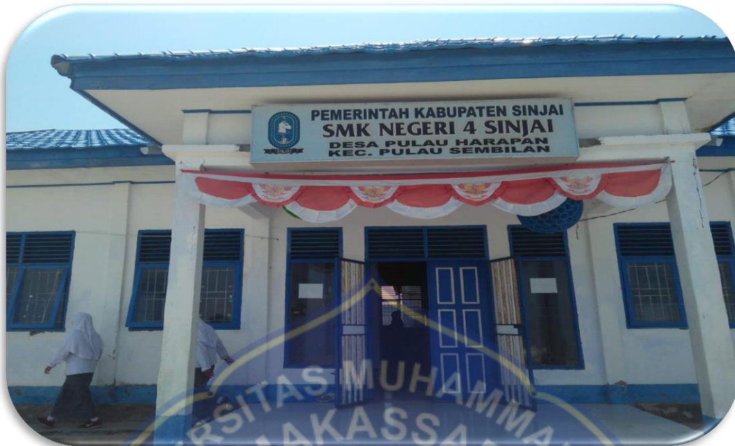
Sekolah SMK Negeri 4 Sinjai Desa Pulau Harapan Kec. Pulau Sembilan Kabupaten Sinjai. Sumber: Dokumentasi foto (Santi: Oktober 2018).
