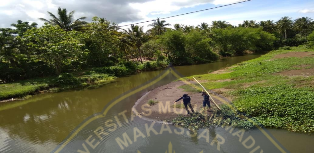
Gambar 1: Penumpukan Sedimen Pada Bendung Suplai Irigasi
