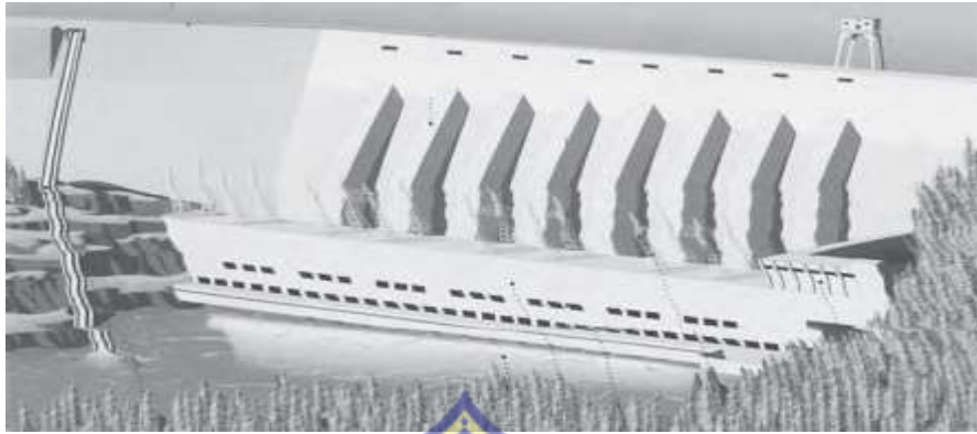
Gambar 2.2 semakin ke bawah, dinding bendungan semakin tebal
