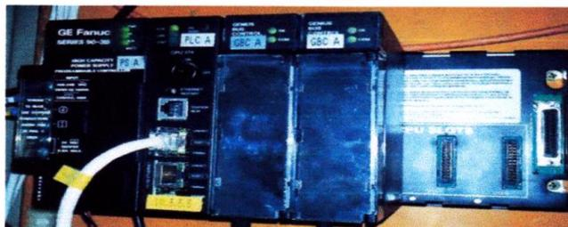
Gambar 4.14 PLC GE Fanuc (CPU, power supply, modul komunikasi)
