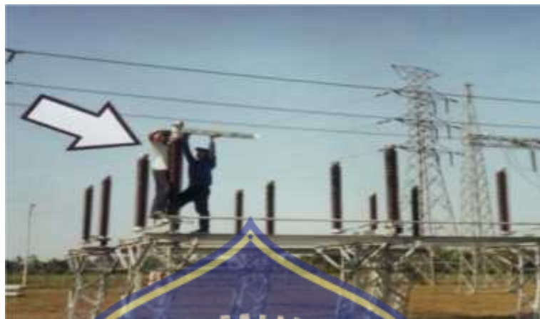
Gambar 2.18. Sakelar Pemisah (PMS) { Disconnecting Switch (DS) }.
