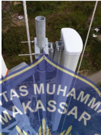
Gambar 4.1 Antena Sektoral Pada BTS
