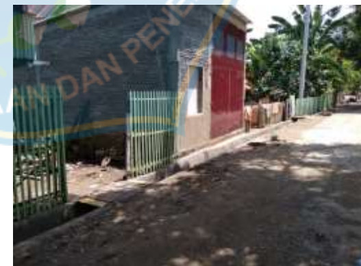
Saluran Drainase setelah di Bangun
