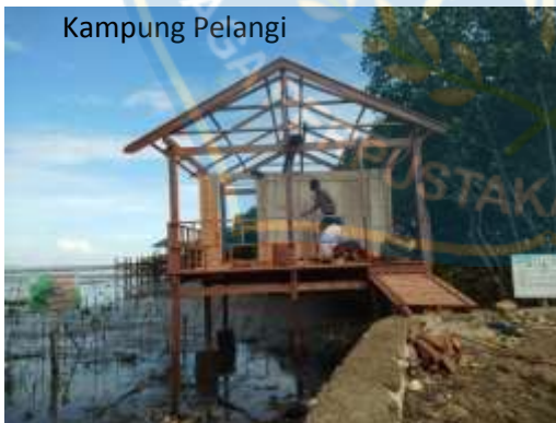
Proses Pembangunan Usaha Warkop
