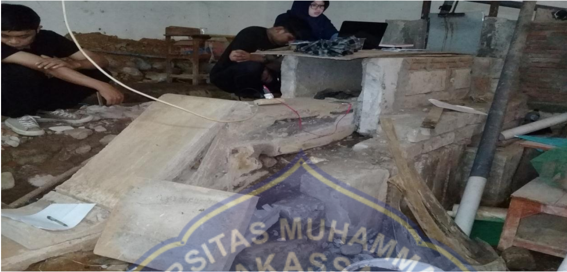
Pembersihan lokasi dalam membuat sebuah saluran dengan ukuran 40 cm x 30 cm x 5,50 m
