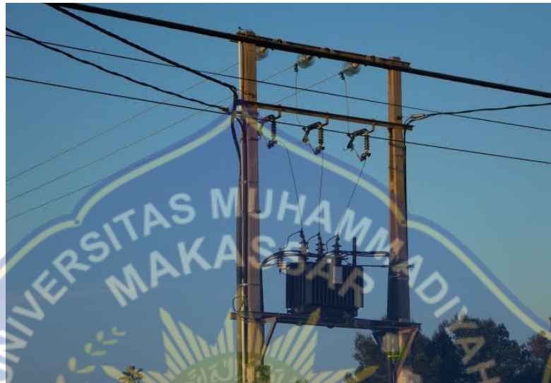
Gambar 2.6 Transformator Distribusi untuk instalasi Gardu Portal
