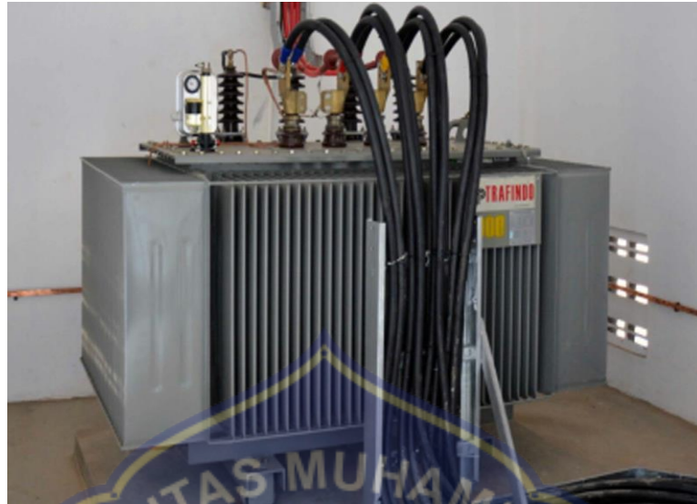
Gambar 2.7 Transformator Untuk instalasi Gardu Beton
