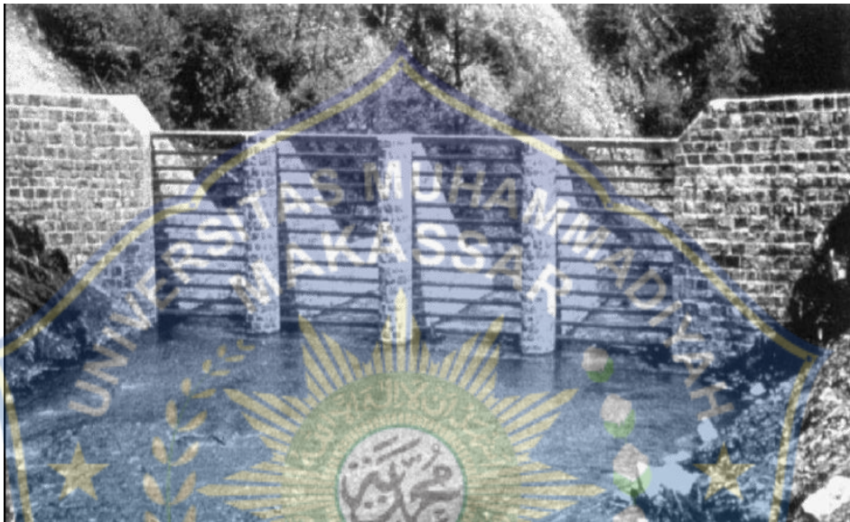
Gambar 6. Cek dam tipe beam di Austria. (Sumber : Armanini dan Larcher, 2001)
