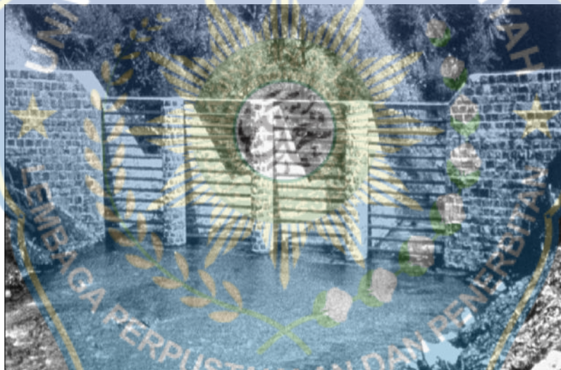
Gambar 7. Check Dam Tipe Beam Di Austria.
