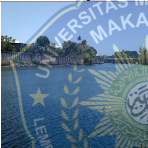
Dinding Penahan menuju ke hilir sebelah kiri sungai Maros
