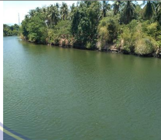
Dinding Penahan menuju ke hulu sebelah kiri sungai Maros
