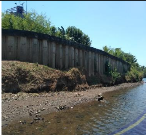
Dinding Penahan menuju ke hulu sebelah kiri sungai Maros
