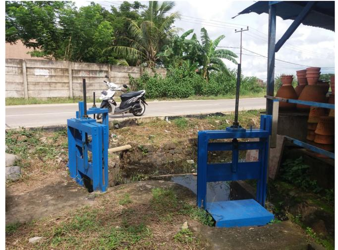
Gambar :2 pintu air sekunder tampak dari samping
