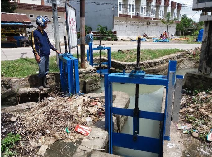
Gambar :1 pintu air sekunder aliran irigasi
